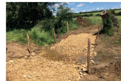
Puis, des travaux d'aménagement des traversées urbaines de Delme et d'Oriocourt seront également prévus avec la création d'un chenal d'étiage. La réduction de la largeur du lit du cours d'eau a pour objectif de dynamiser les écoulements et ainsi d'éviter l'envasement du ruisseau.
